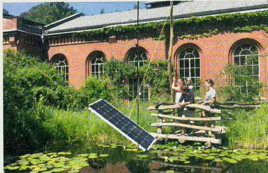
Ein Solarpaneel versorgt nun die Teichpumpe mit Strom. Foto: Christine Kehl
